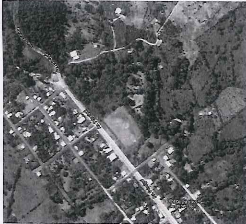
Ilustración 1- Ubicación Subestación Pedro Vicente Maldonado
